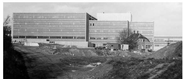
Viborg Centralsygehus Varmegenvinding med glasrørvarmevekslere
